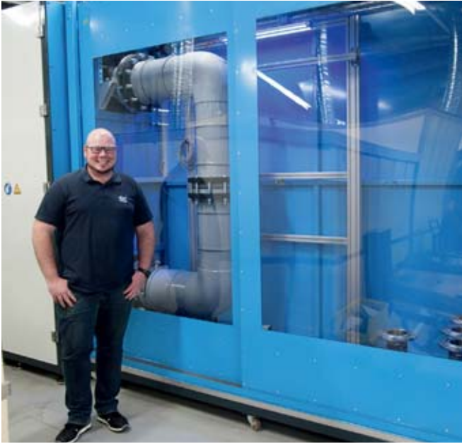
Bild 2: Martin Winkler vor einem Prüfstand für 315-mm-Rohre
