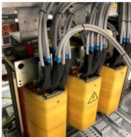
Bild 3: Die Sekundärwicklungen des Filters sind als Lagenwicklungen ausgeführt, die jeweils mit Gießharz-impregnierten Papier-Isolierlagen ausgeführt sind
