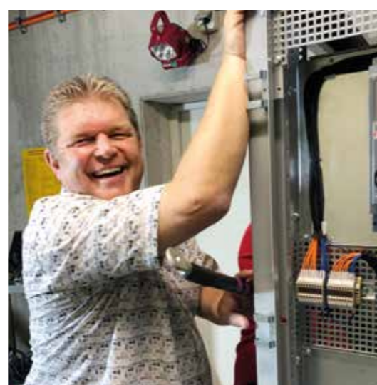
LIVARSA Installationsexperte Jörg Fink im Einsatz
